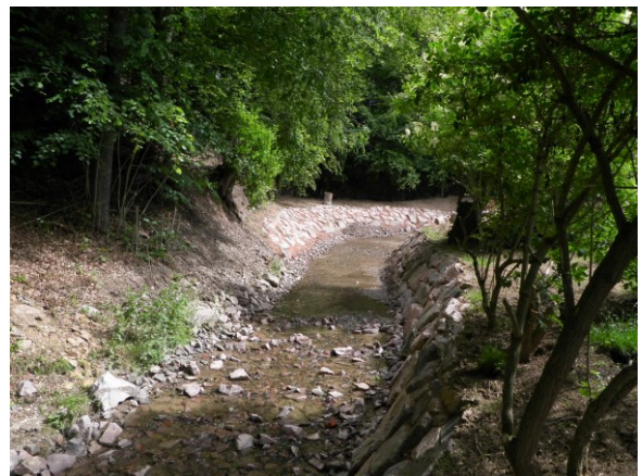
Zustand nachher - durchgängige Sohle, Böschungssicherung mit Natursteinen, Weidensetzstangen
