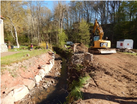
Bauzustand - Mauer wird in Böschung umgelegt
