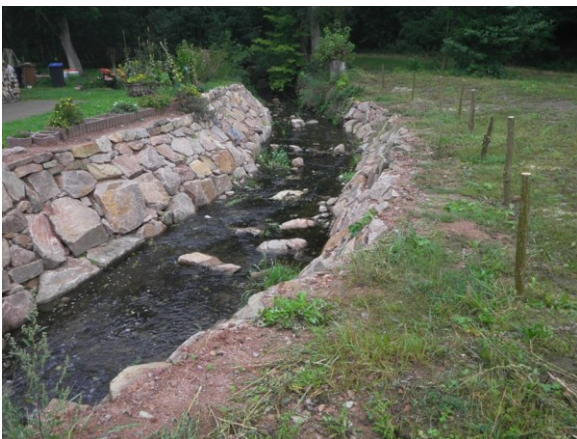
Zustand nachher - Böschung mit Natursteinen und durchgängige Sohle, Weidensetzstangen
