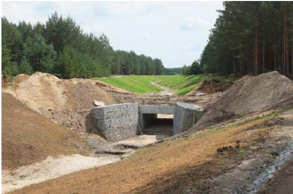
Errichtung von Durchlässen an den vorhandenen Wegbeziehungen
