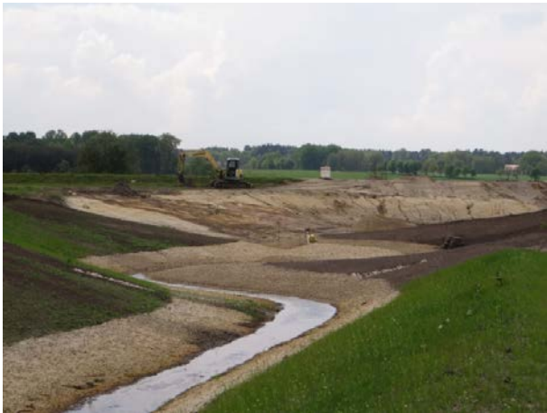
Laufende Bauarbeiten am Modergraben 2017
