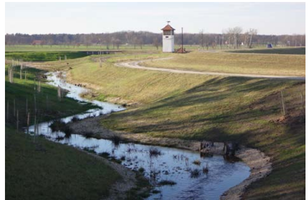
Modergraben kurz nach der baulichen Fertigstellung
