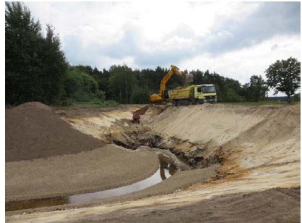
Laufende Bauarbeiten am Modergraben 2017
