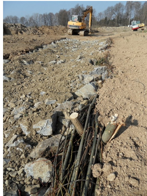
Bauphase Februar 2014– Detailaufnahme Einbau ingenieurbio- logischer Elemente
